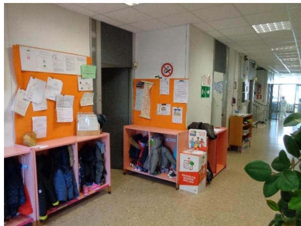
Figura 4.16 - Particolare dei corpi illuminanti ubicati nei corridoi
