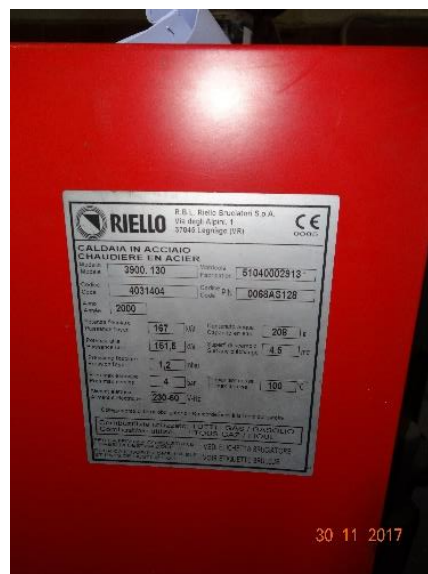
Figura 4.11 - Targhetta caldaia
