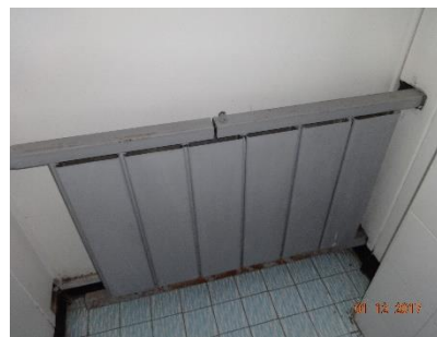
Figura 4.6 - Particolare installazione radiatori
