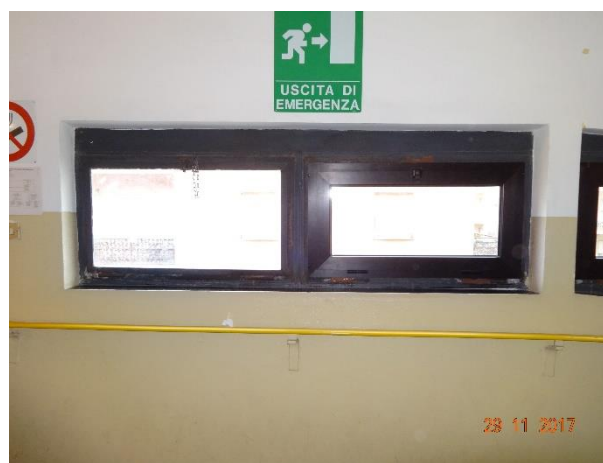
Figura 8.1 – Particolare dei serramenti esistenti
