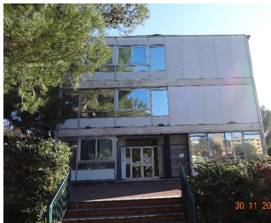
Figura 1.1 - Vista della facciata Nord-Ovest
