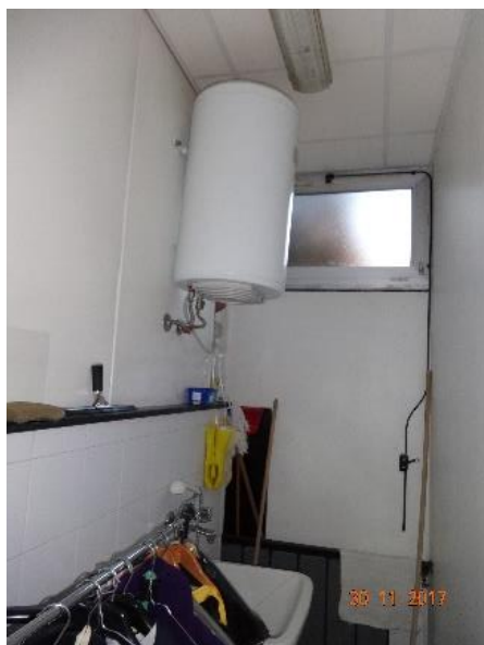
Figura 4.12 - Boiler elettrico tipo
